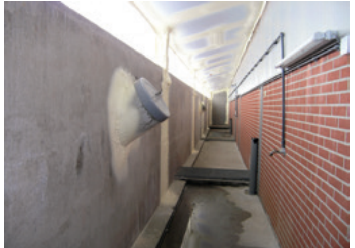
Naast de zeugenstal werd over de hele lengte van de zijgevel een extra gang gebouwd die meteen ook de bestaande luchtinlaten overkapt.
