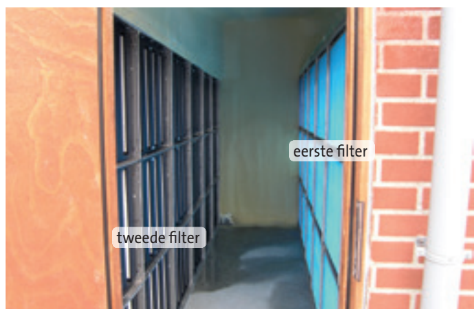
Elke unit heeft drie lagen: een wasbare stoffilter haalt de grove organische deeltjes uit de buitenlucht en beschermt de tweede filter. De tweede filter, een F7 volgens Europese normen vangt meer dan 88 procent van de viruspartikels uit de lucht en beschermt de derde filter.
